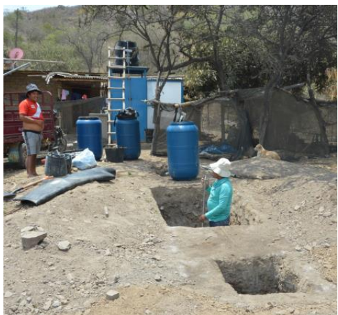
Bau einer Bio-Kläranlage
