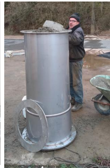
Betonieren des Filters
